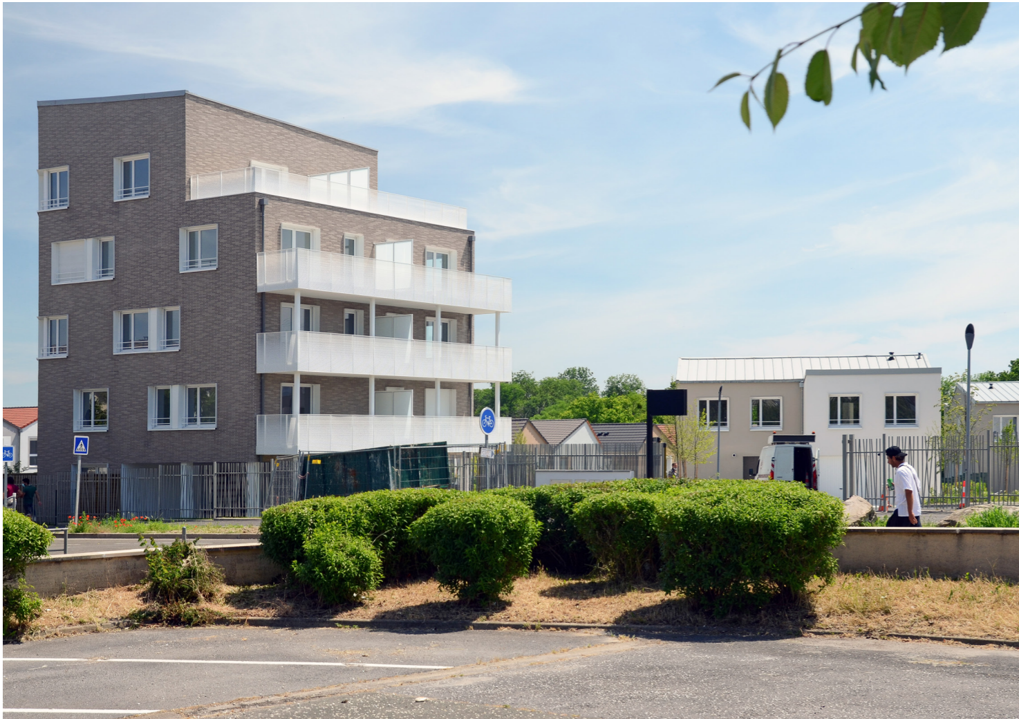
Depuis l'avenue Adolphe Chauvin
