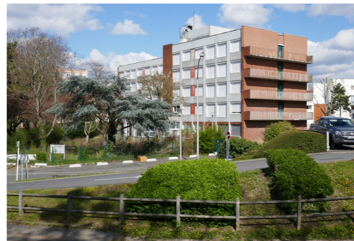
Façade Sud-Ouest depuis la rue Benjamin Constant
