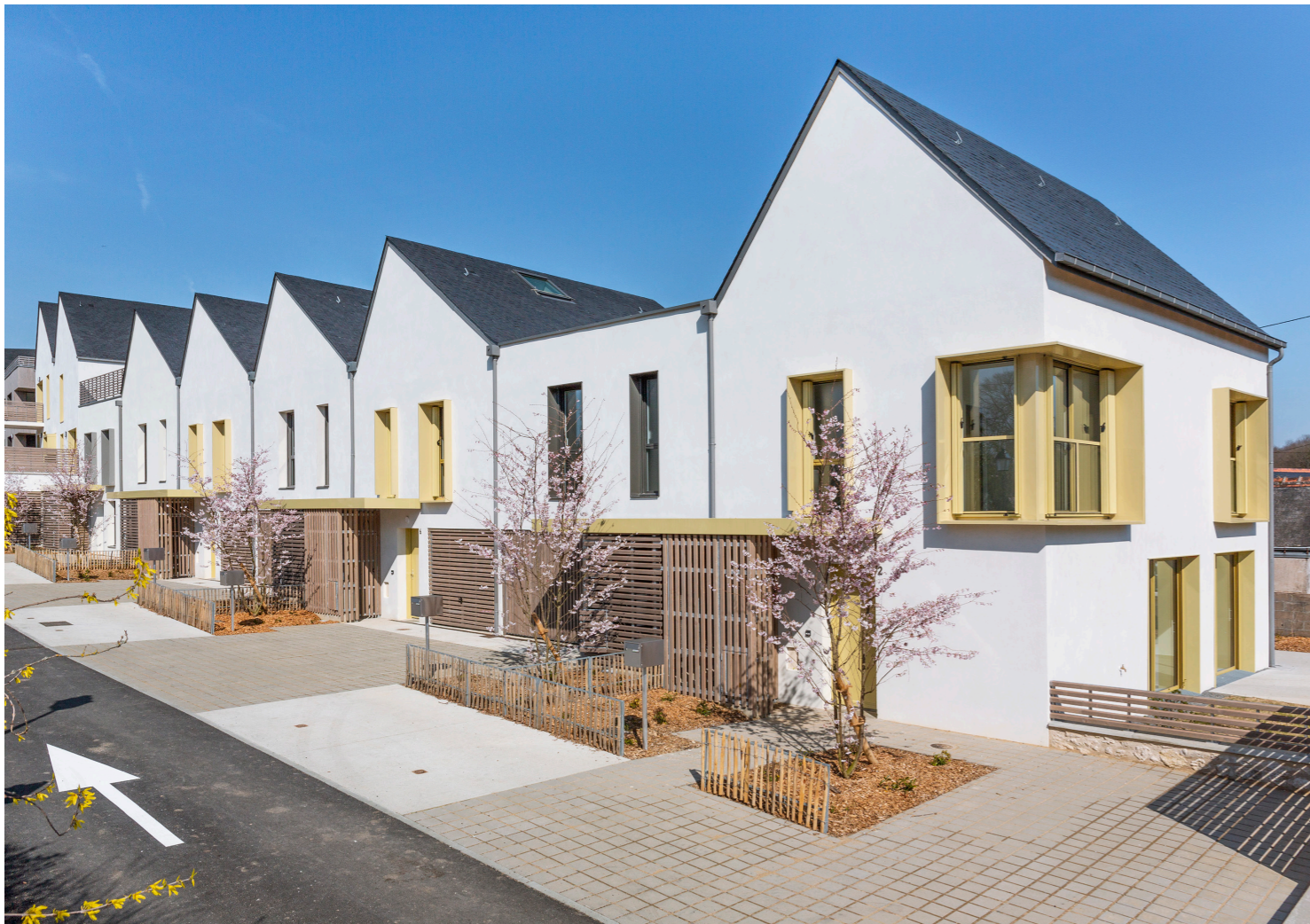
Les maisons depuis l'entrée sud
