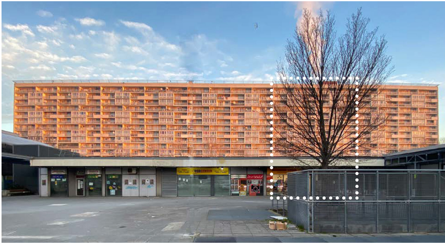
Façade Sud Bâtiment Mail de Fontenay
