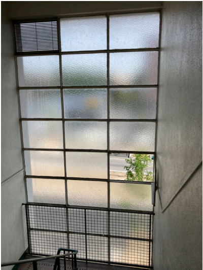
Baie vitrée parties communes
