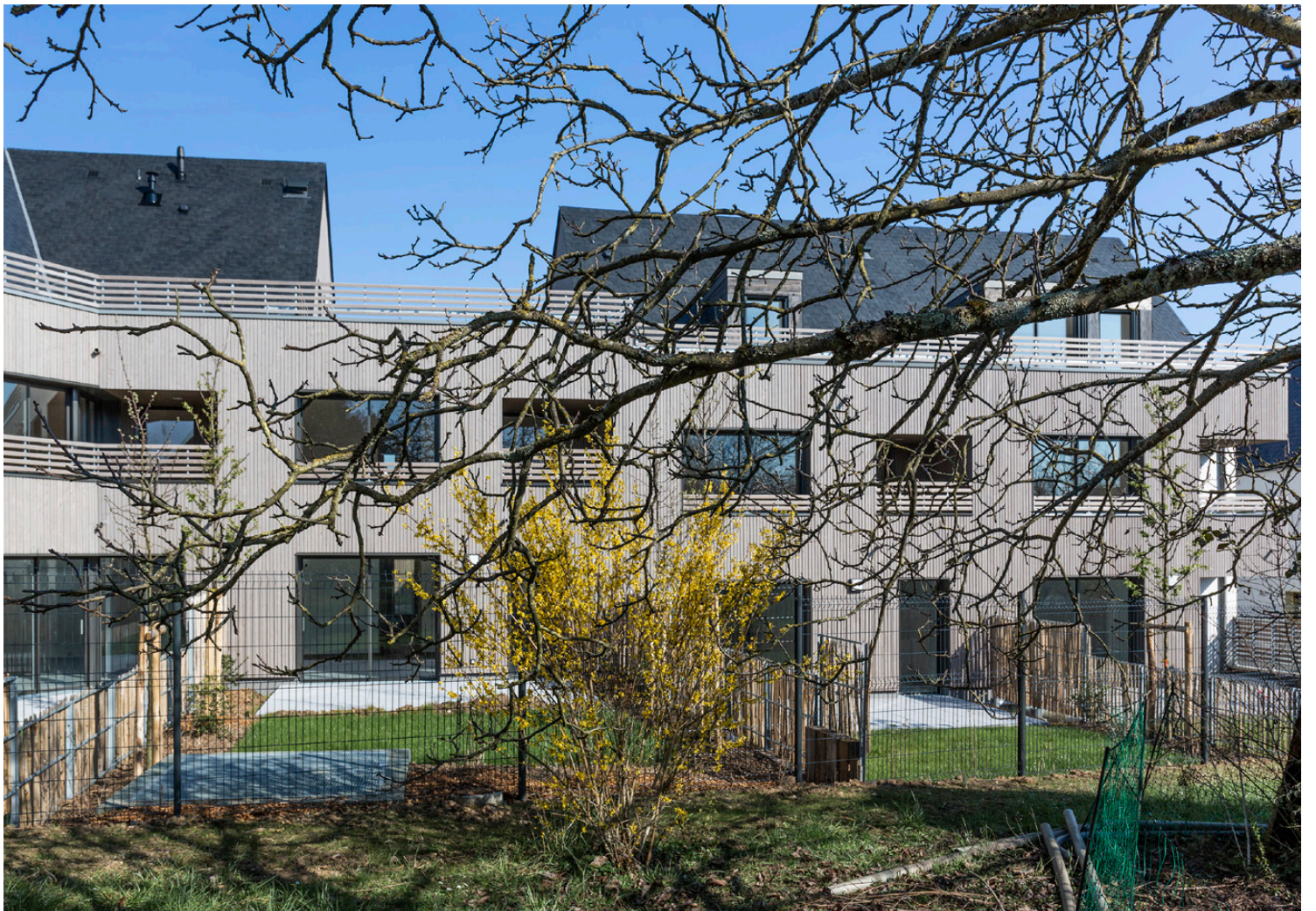
Les logements collectifs depuis les jardins privés
