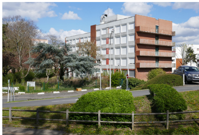
Façade Sud-Ouest depuis la rue Benjamin Constant
