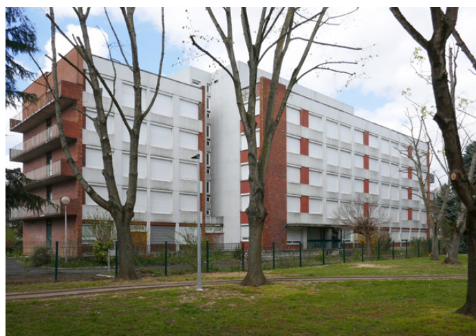
Façade Nord-Ouest depuis le Petit Bois
