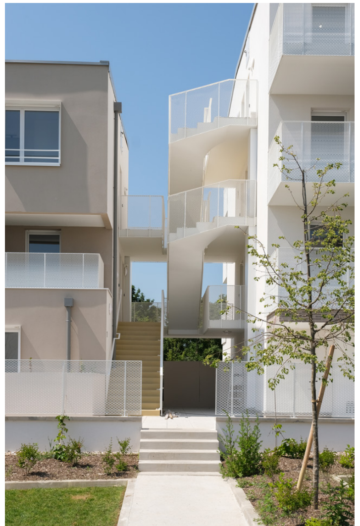
Les distributions extérieures des logements intermédiaires
