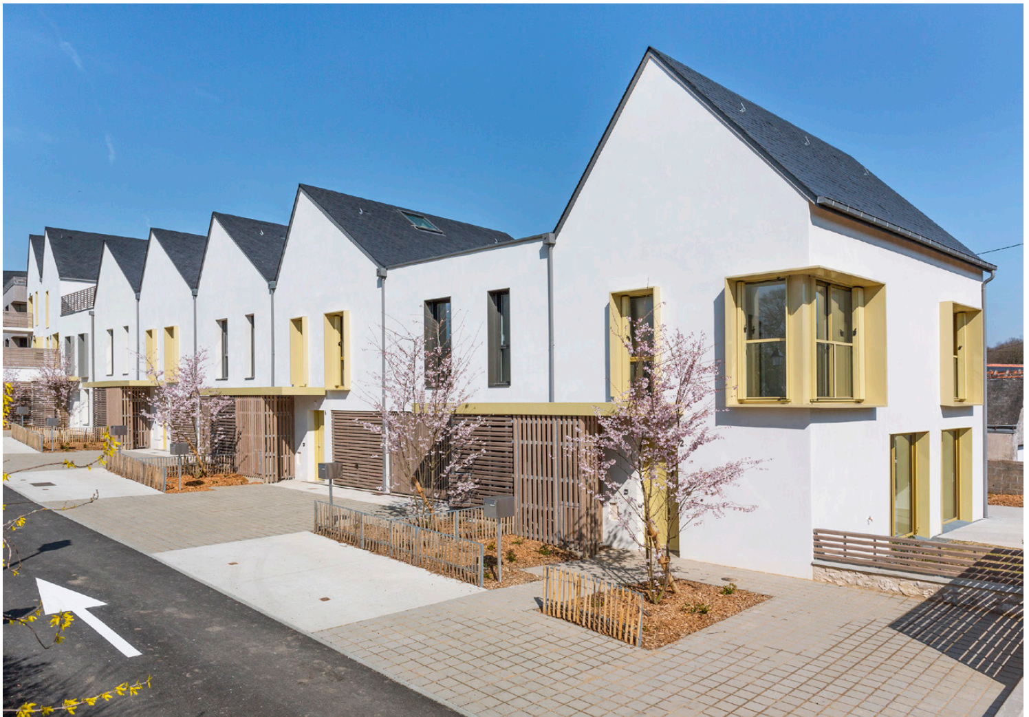
Les maisons depuis l'entrée sud
