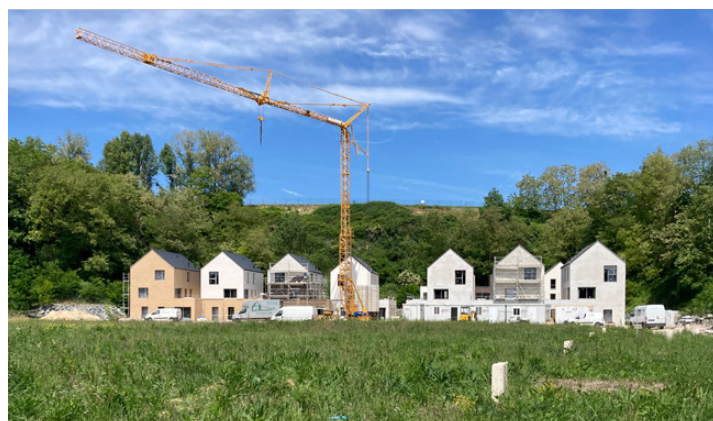
Chantier en cours
