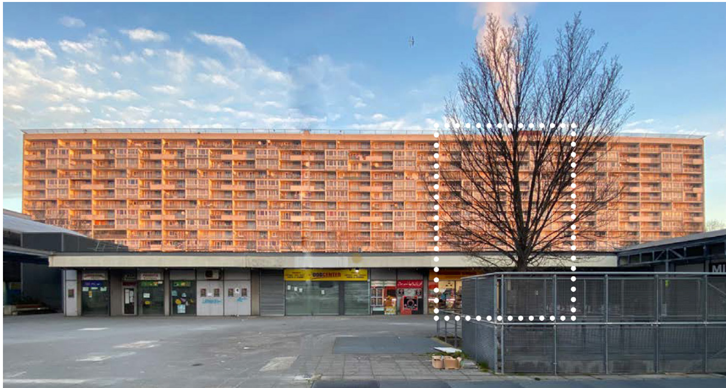
Façade Sud Bâtiment Mail de Fontenay
